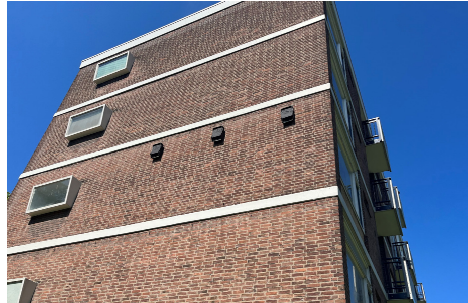
Figuur 22: Vleermuiskasten (Veiligheid) aanwezig op de zuidgevel in de Staatsliedenbuurt. Het is belangrijk dat de kasten aan meerdere zijden van het gebouw worden geplaatst i.v.m. variatie aan bezonning en wind.
